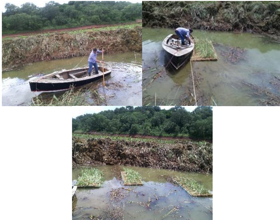
Figura 27 - Colocação dos leitos flutuantes na ribeira do Roxo.
