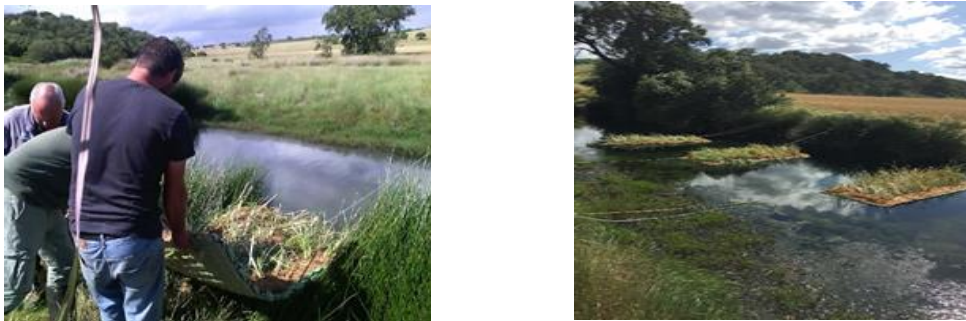
Figura 28 - Colocação dos leitos flutuantes na ribeira de Água Forte.
