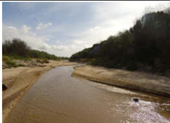
Vista para montante
