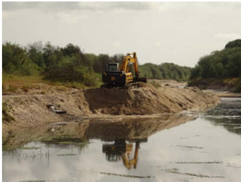
Fotografia 2.1 – Extração de inertes num trecho da ribeira de Sor a jusante da barragem (AQUALOGUS, maio 2020).
