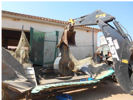
Figura 4 – Desmontagem da caixa vibratória da unidade esquerda da MCCA
