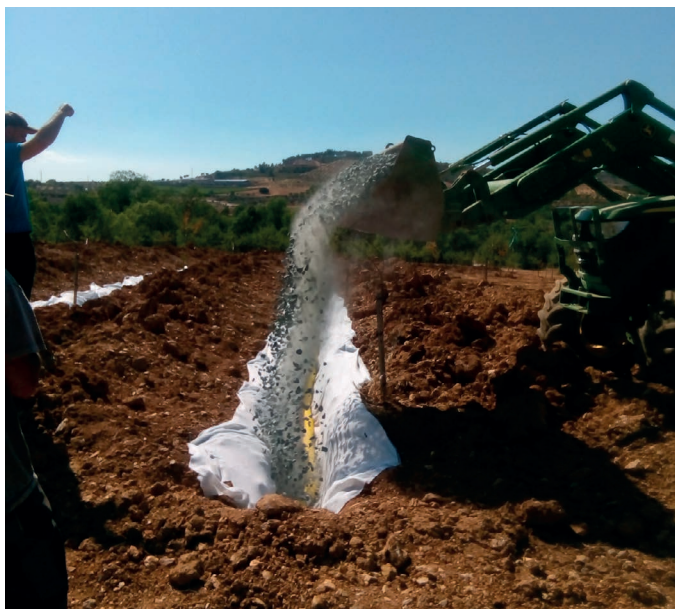
Figura 1 – Aplicação de tubagem geodreno perfurada e manta geotêxtil em amendoal.
