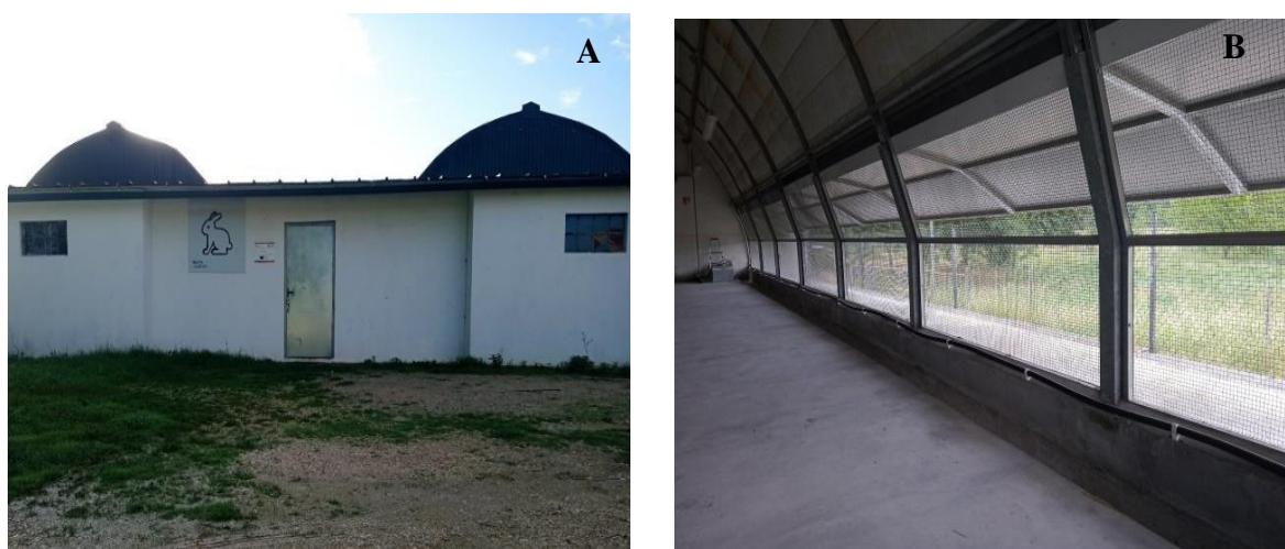
Figura 2- Instalações do Ensaio 1, na ESAC. A- Entrada principal da exploração; B- Entradas de ar e iluminação com rede mosquiteira do túnel de produção.
